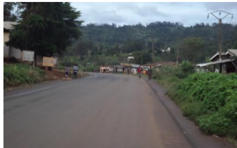
Photo 11: Un tronçon de la régionale P15 au niveau de l'EP de Bana
