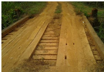
Photo 4: Pont fait en matériaux provisoires à Bakassa
